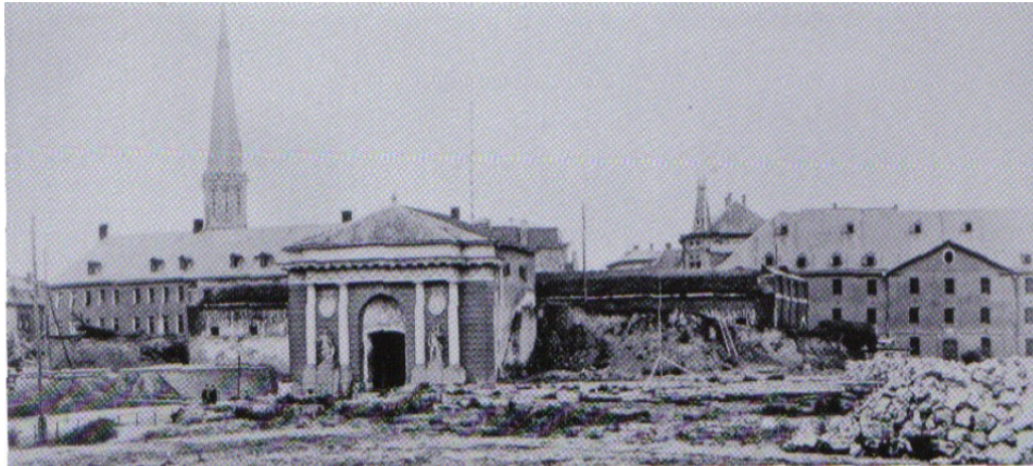
Abriss der Festungsmauern am Berliner Tor.
